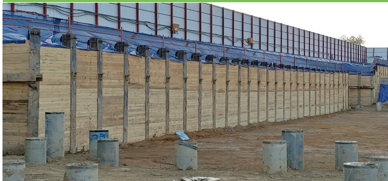
원설계: H-PILE+STRUT 3단
