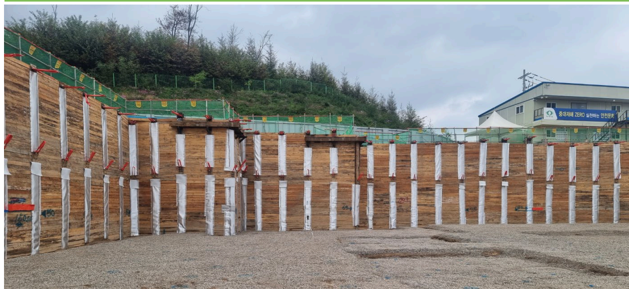
원설계: H-PILE+STRUT 3단
