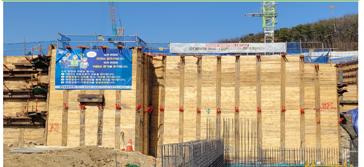
원설계: H-PILE+RAKER 4단
