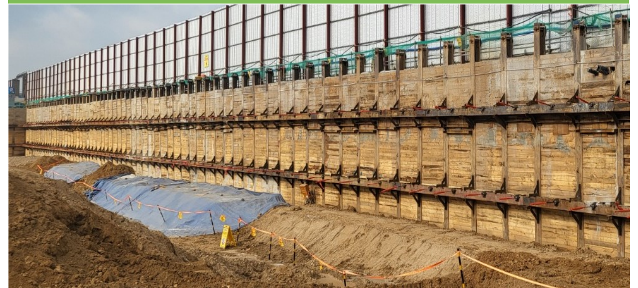
원설계: H-PILE+RAKER 3단
