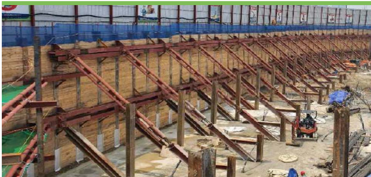
원설계: H-PILE+RAKER 5단
